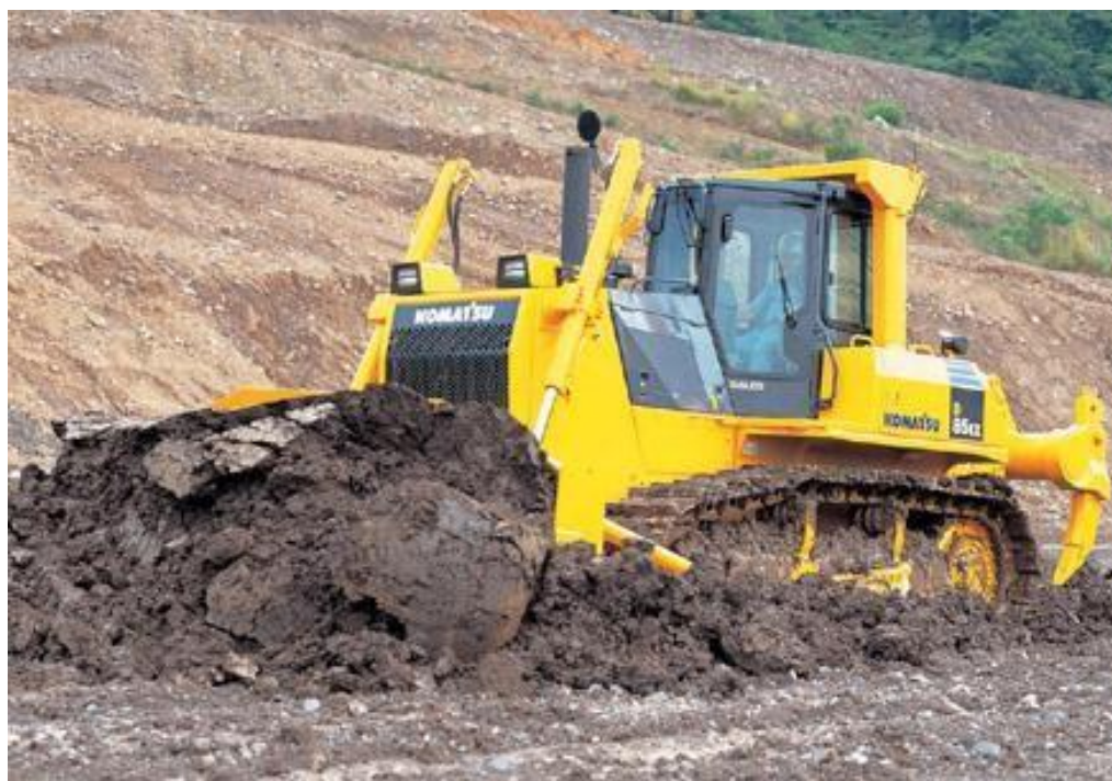
Рисунок 1 – Дорожно-строительные работы с применением бульдозера
